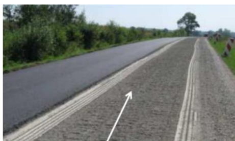
Rozsypywanie cementu w ilości 1,5 - 7,0 %
