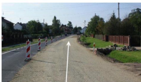
Rozkładanie kruszywa w celu optymalizacji uziarnienia
